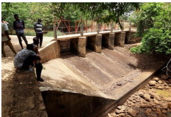
Figure 55 - Photo mission : retenue de Kada avec prise d'eau envasée, non-opérationnelle depuis 1975 (auteurs, 2021)
