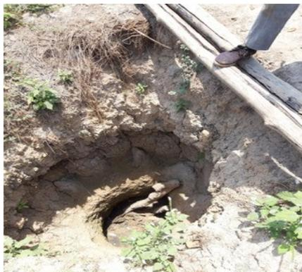
Figure 89 - Photo mission : puits traditionnel éboulé (auteurs, 2021)
