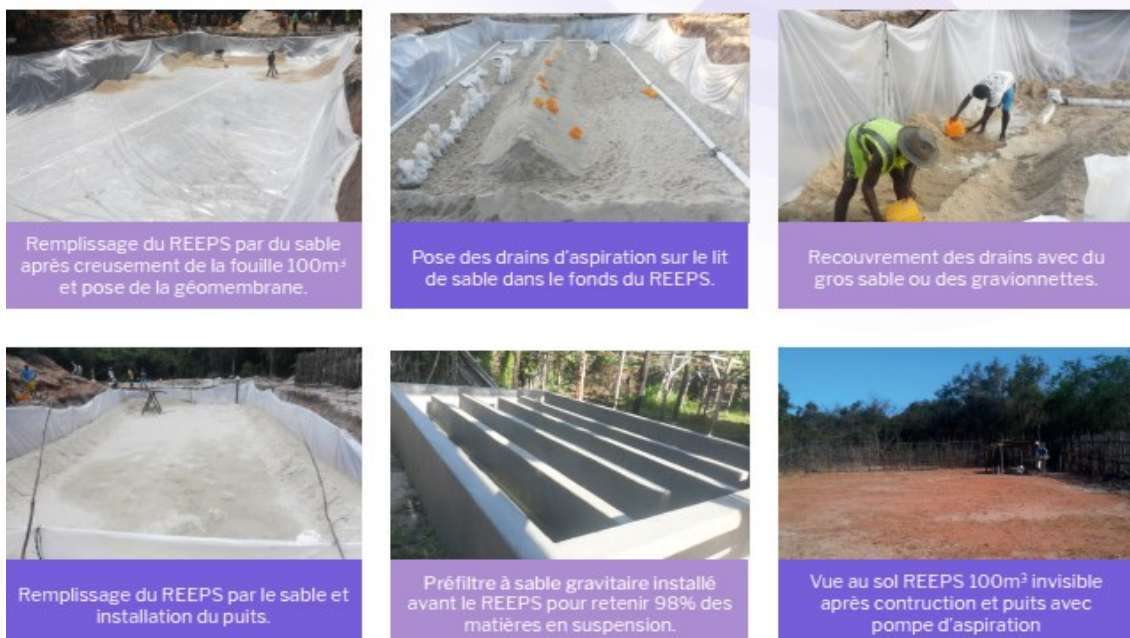
Figure 45 - Photos des étapes de montage d'un REEPS de 100 m 3 utile (ENERGIS FD, 2018)
