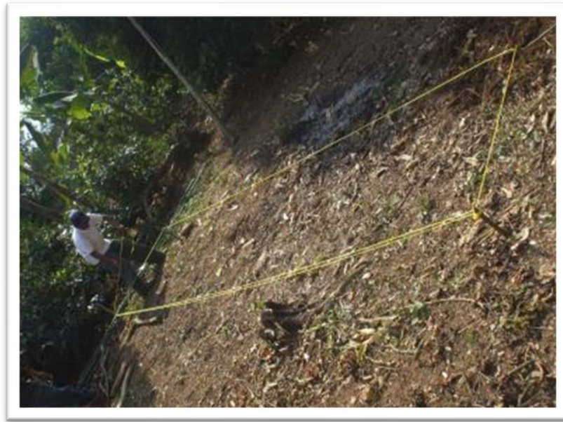
Ilustración 7: Trazo del camellón en el terreno.
