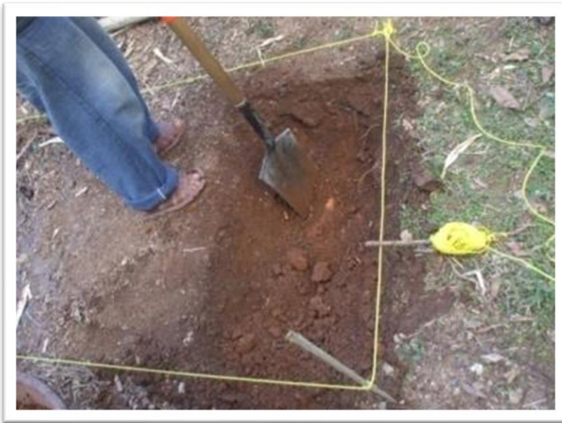
Ilustración 8: Preparación de una cama de doble excavación.
