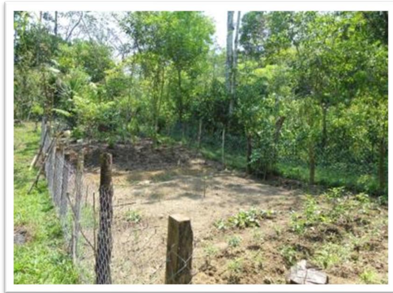
Ilustración 6: Limpieza y protección del terreno
